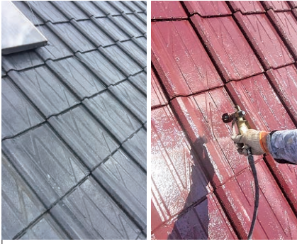
●甲佐町・Oさん邸【セメント瓦屋根塗装】 塗装前(左)と塗装後(右)。熱と紫外線をはじき返す遮熱塗装でツヤツヤ光沢のある仕上がりに!
