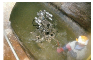
テレビカメラ調査等により、管さよの状態を調べています
