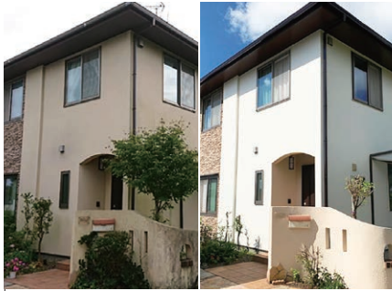
●玉名市・Oさん邸【壁・屋根塗装】 色あせしていた壁、傷みがひどかった屋根を遮熱塗装で塗り替えて、新築のような仕上りに。「ピカピカになった!」と施工さんも大変喜ばれたそう
