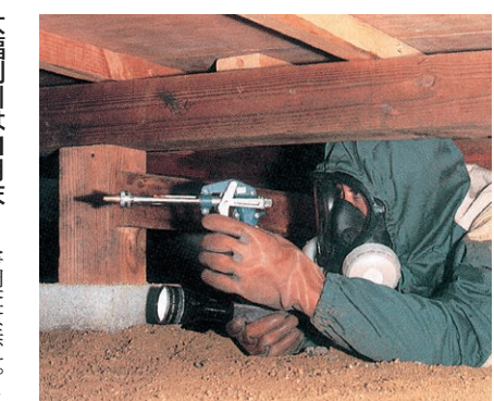
安全性に配慮した薬剤を床下に直接散布。シロアリの侵入を防ぐ効果が最長5年も持続します
